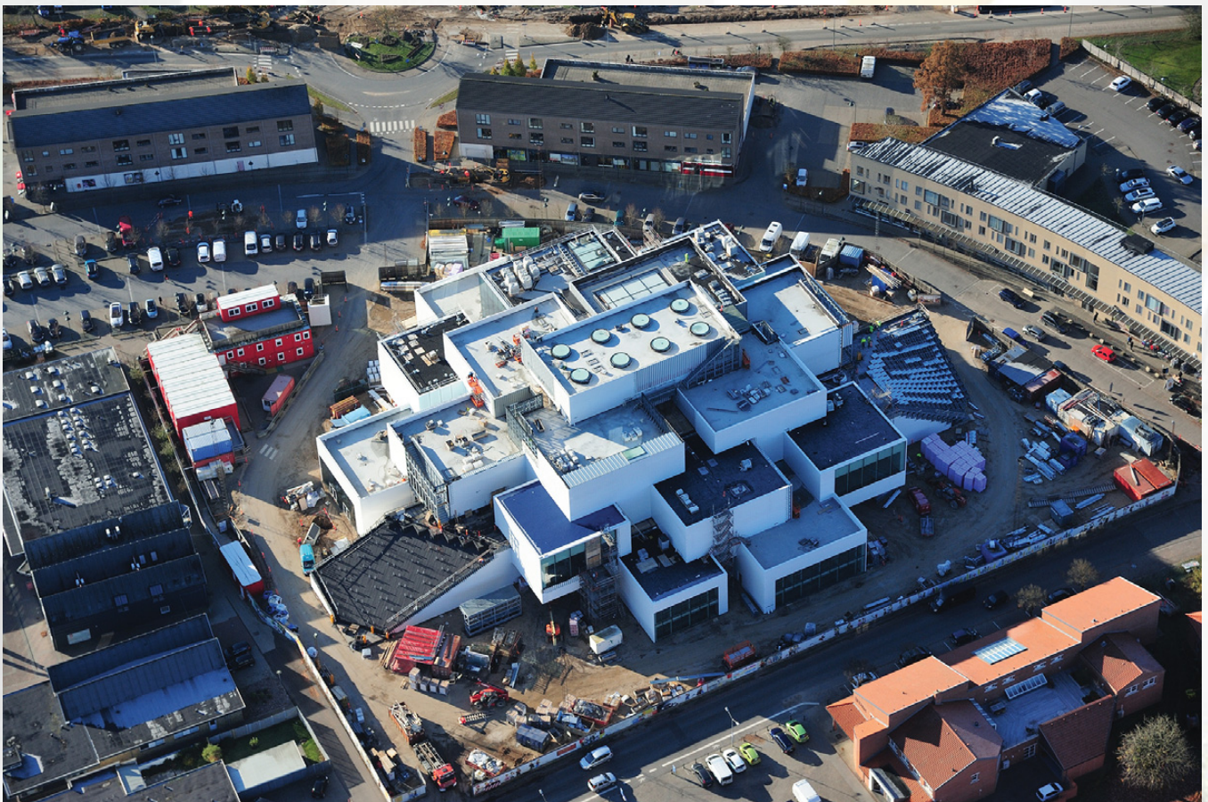
Obras de la LEGO® House
