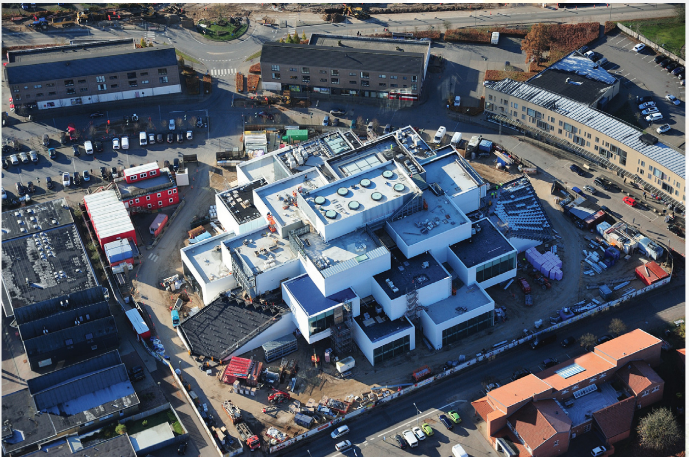
Obras de la LEGO® House
